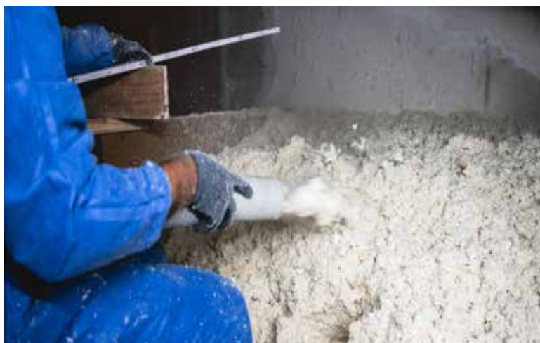
FOT. 3 Materiał izolacyjny Quate Cellulose firmy Suprema pozyskany z recyklingu (źródło: Suprema)
