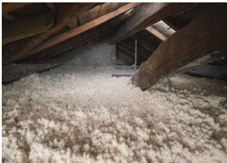
FOT. 4 Materiał izolacyjny Quate Cellulose firmy Suprema pozyskany z recyklingu (źródło: Suprema)
